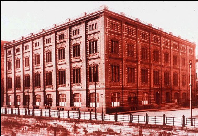
SCHINKEL, Bauakademie (Academia de Arquitetura), 1831-35, destruída em 1961, Schlossplatz, Berlim
