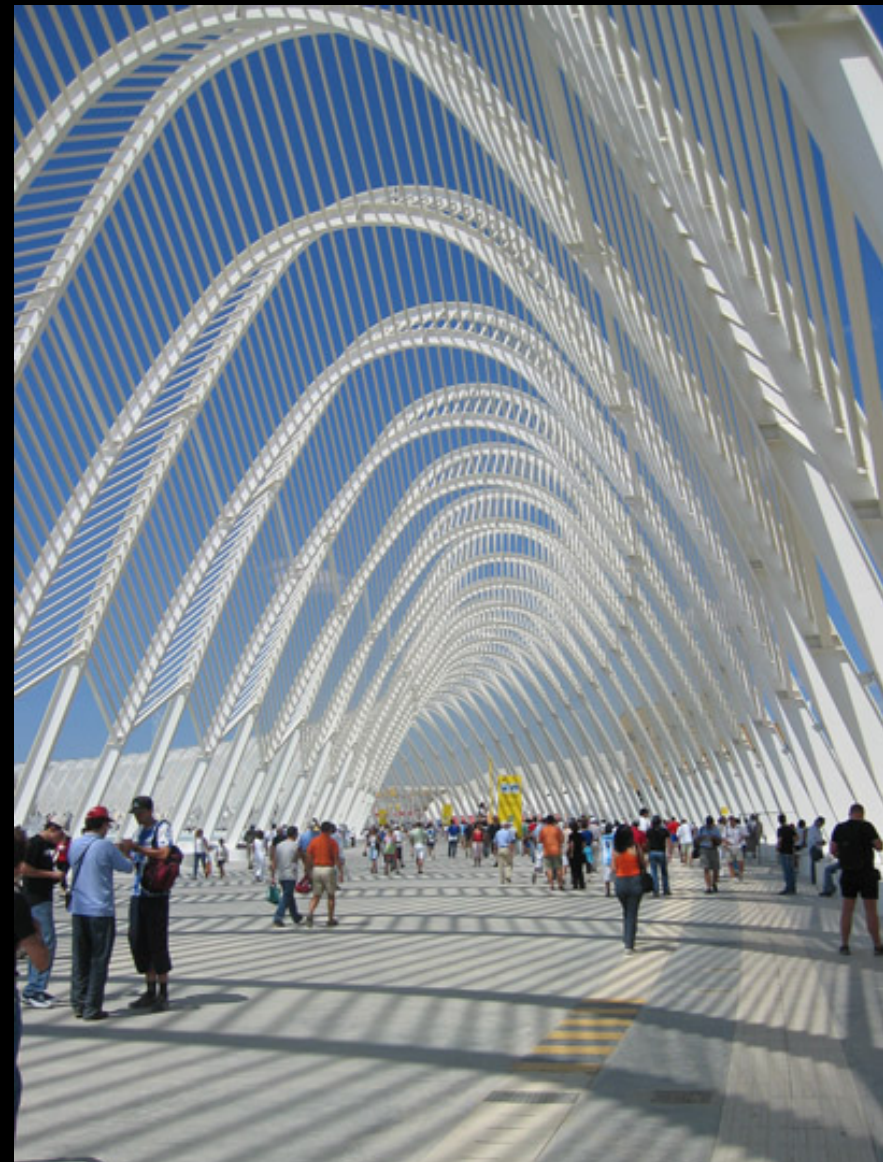
Santiago CALATRAVA (1951) Stoa Olímpica Complexo Olímpico, 2004 Atenas
